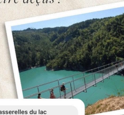
Les passerelles du lac de Monteynard
