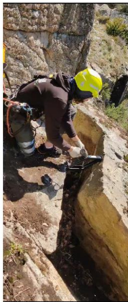
Purge et déroctage Sécurisation des parois et des accès
