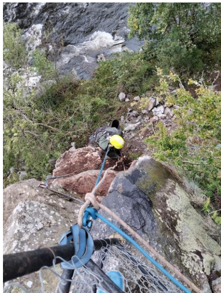
Défrichage et démoussage des falaises
