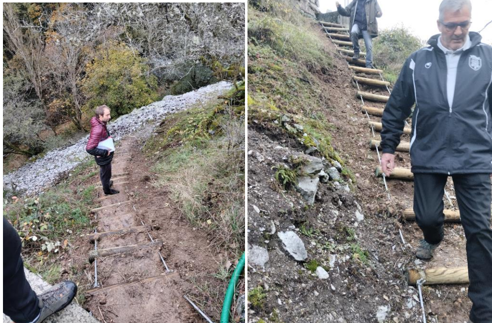
Aménagement des accès, et pieds de parois
